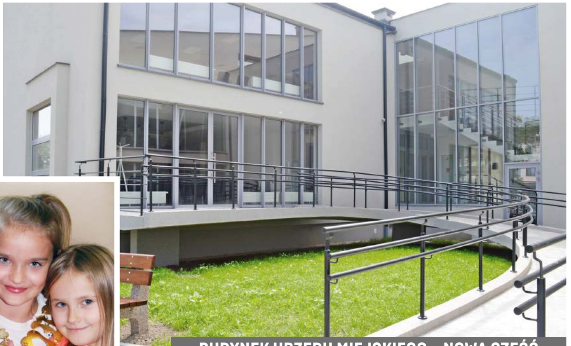
BUDYNEK URZĘDU MIEJSKIEGO – NOWA CZĘŚĆ
